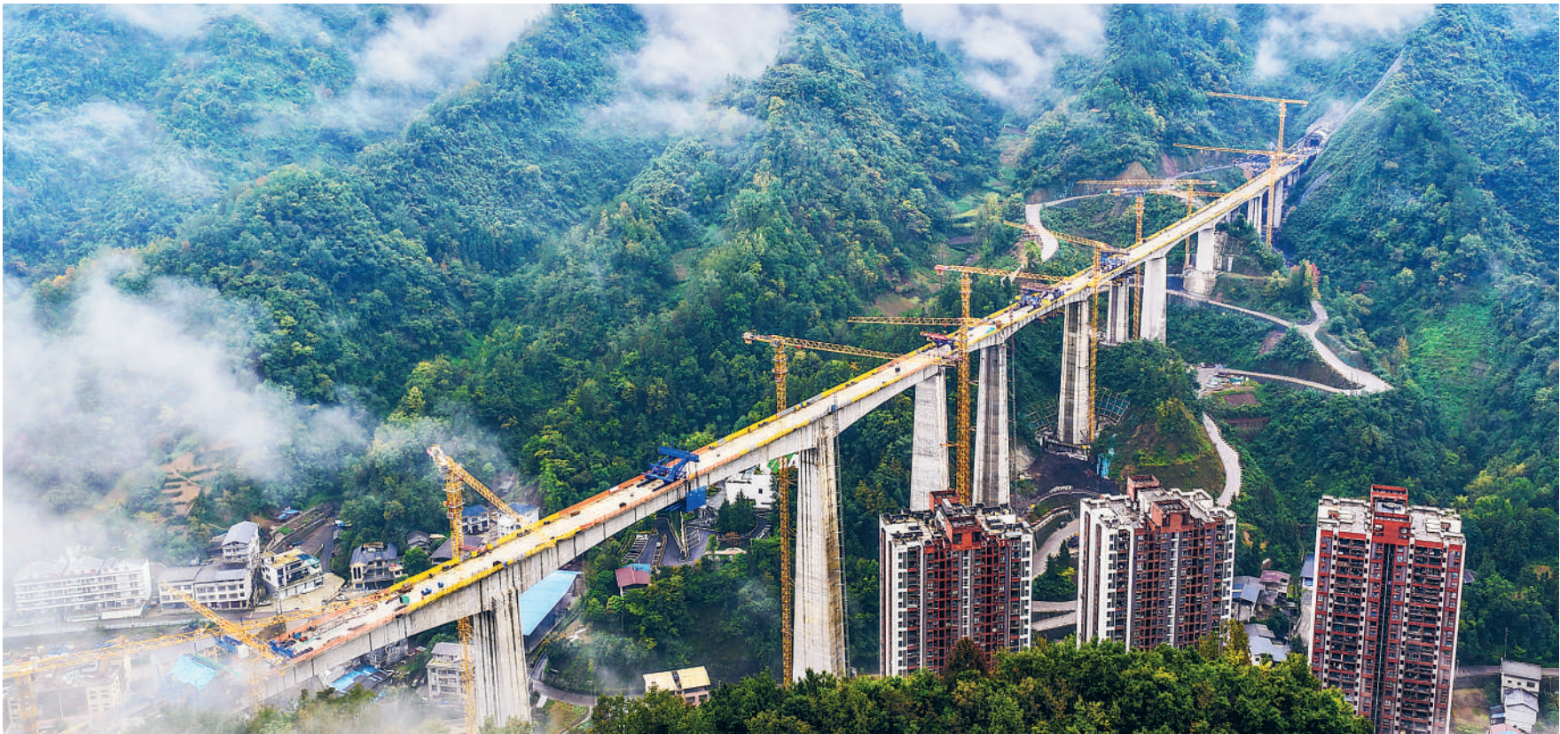
10月12日,西渝高铁梁栾特大桥顺利合龙,为全线如期通车奠定了坚实基础。梁栾特大桥位于重庆市城口县境内,全长941.6米。大桥采用6联、15跨连续梁结构,集多跨、大跨径、超高墩群于一体,最大跨径136米,最高墩达103.5米。图为当日拍摄的西渝高铁梁栾特大桥建设现场(无人机照片)。
