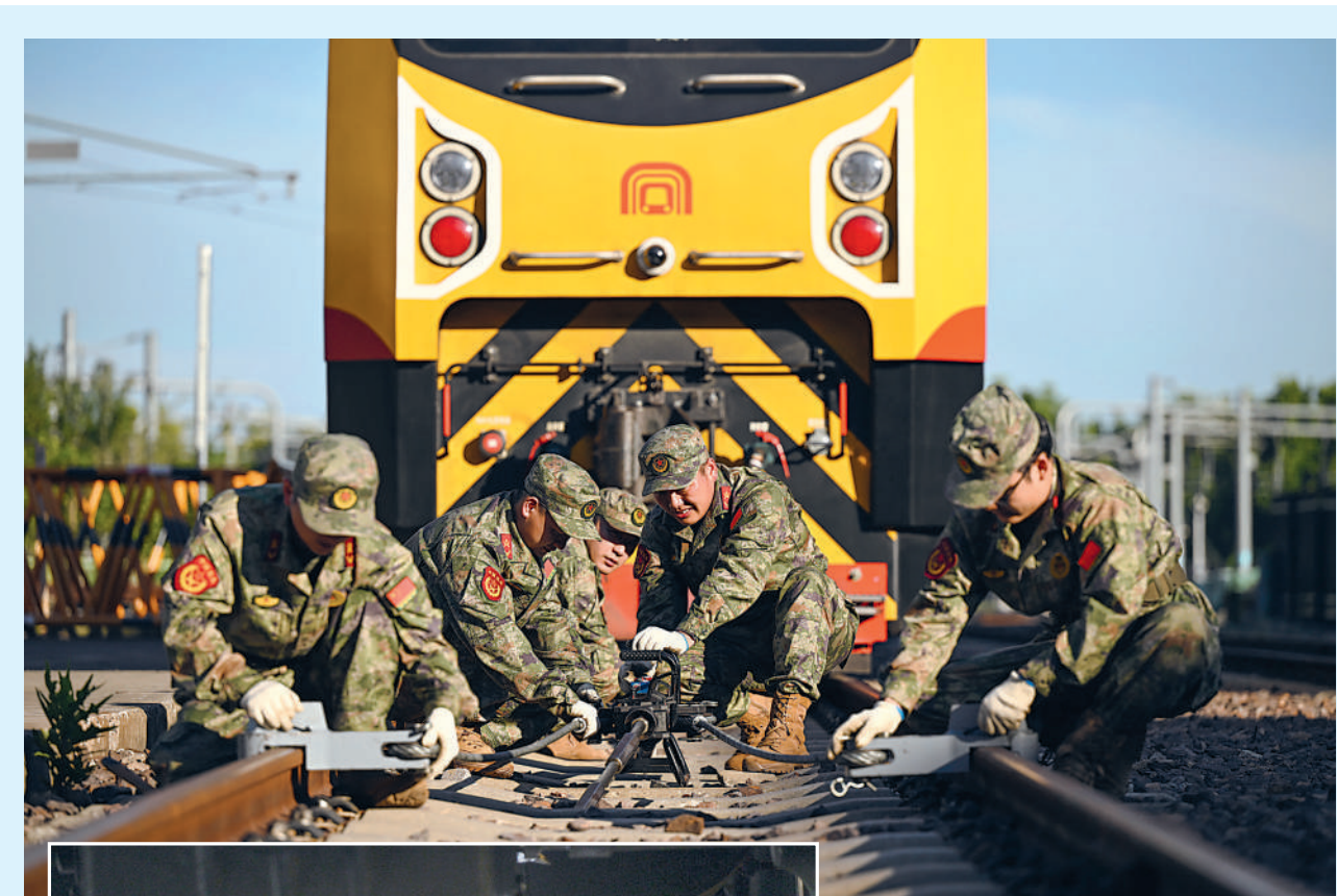
近日,安徽省合肥市庐阳区开展轨道应急救援训练,通过设置损坏钢轨更换、故障列车转运等课目,提高民兵队伍抢险保通能力。
