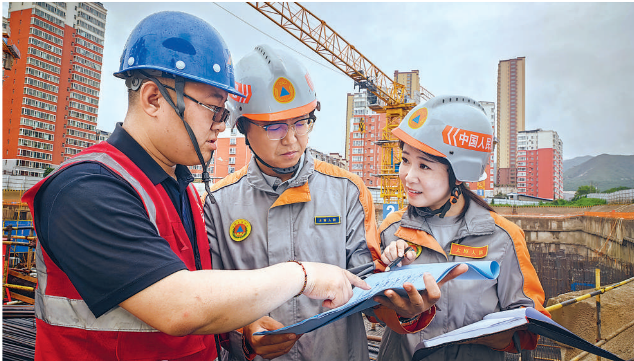
山西省太原市注重抓好人防工程质量监督。近日，在万柏林区东社街道，工作人员正在对一个在建人防工程施工情况进行检查。
