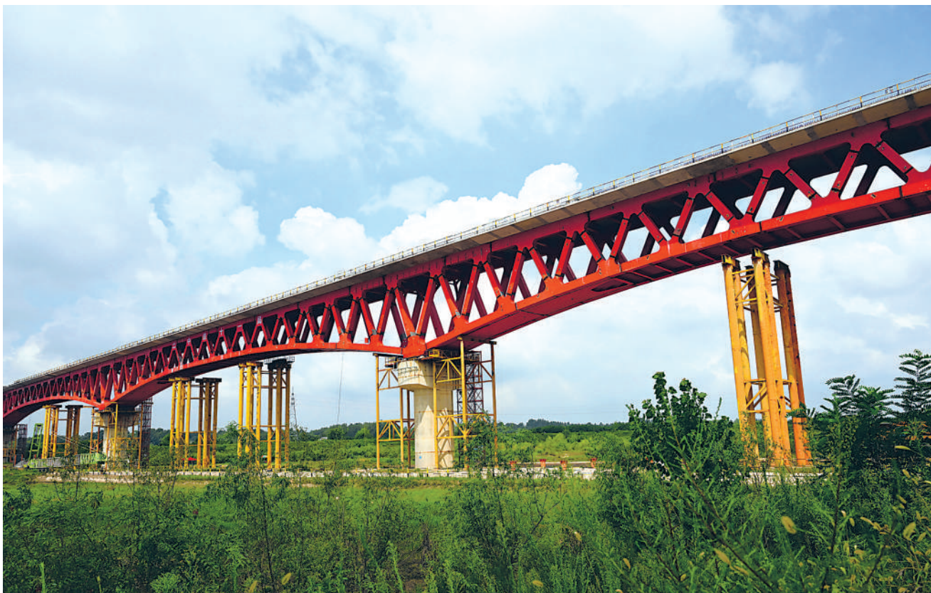
8月21日,由皖赣铁路安徽公司建设管理、中铁十一局承建的合武高铁安徽段重难点工程——金寨史河特大桥钢桁梁主体工程完工。图为当日拍摄的施工现场。 新华社记者 周牧摄
