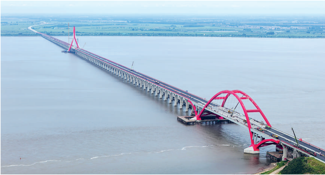
八月十八日，哈尔滨都市圈环线北环水源至双北环项目核心节点全线贯通，为通车筑牢基础。图为当日拍摄的大桥合龙现场。新华社记者 张涛摄
