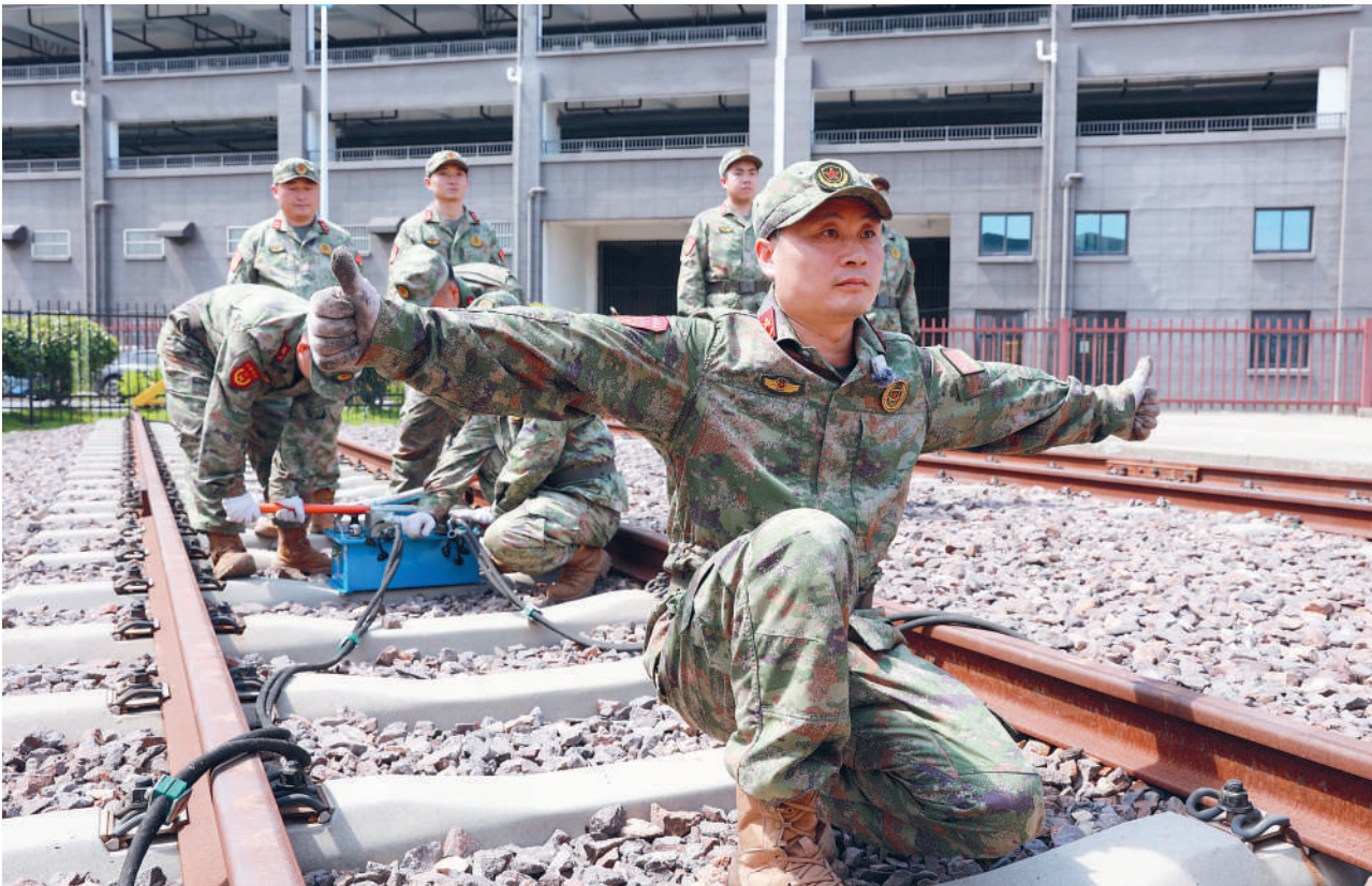
近日,安徽省合肥市瑶海区人武部组织民兵赴合肥市轨道交通集团有限公司接受专业技能培训。图为民兵进行起复作业。王玉鸿摄
