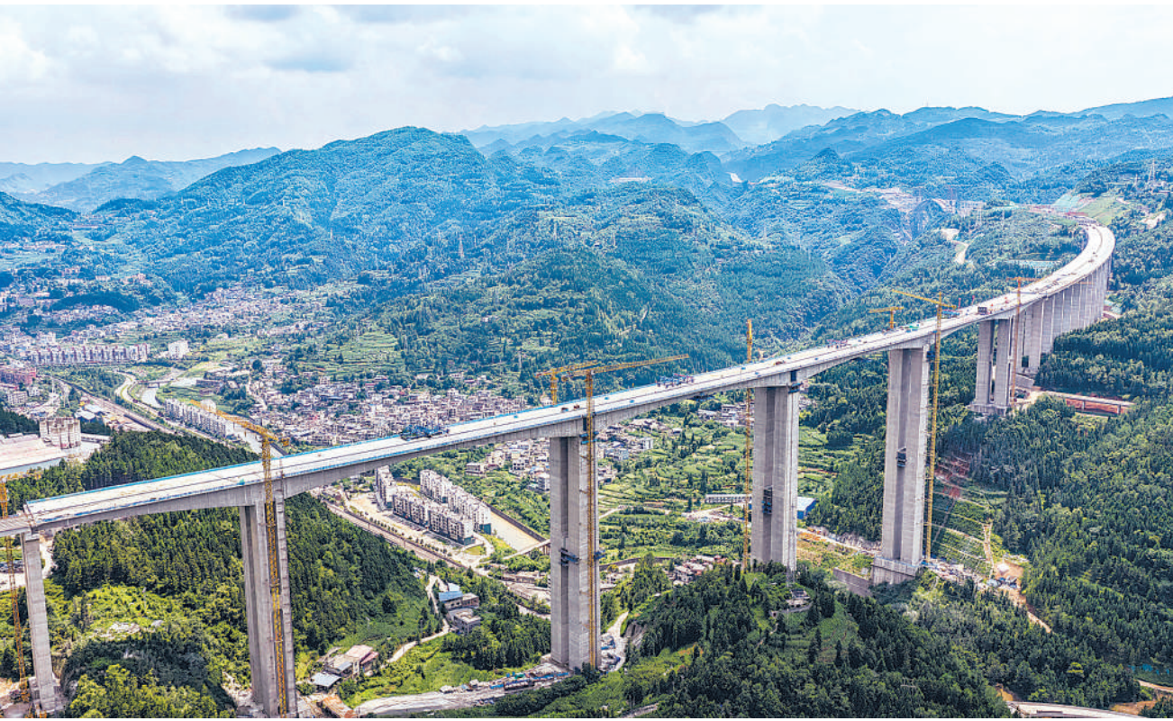
7月16日，安（顺）盘（州）高速公路盘关特大桥主桥顺利实现合龙（无人机照片）。
