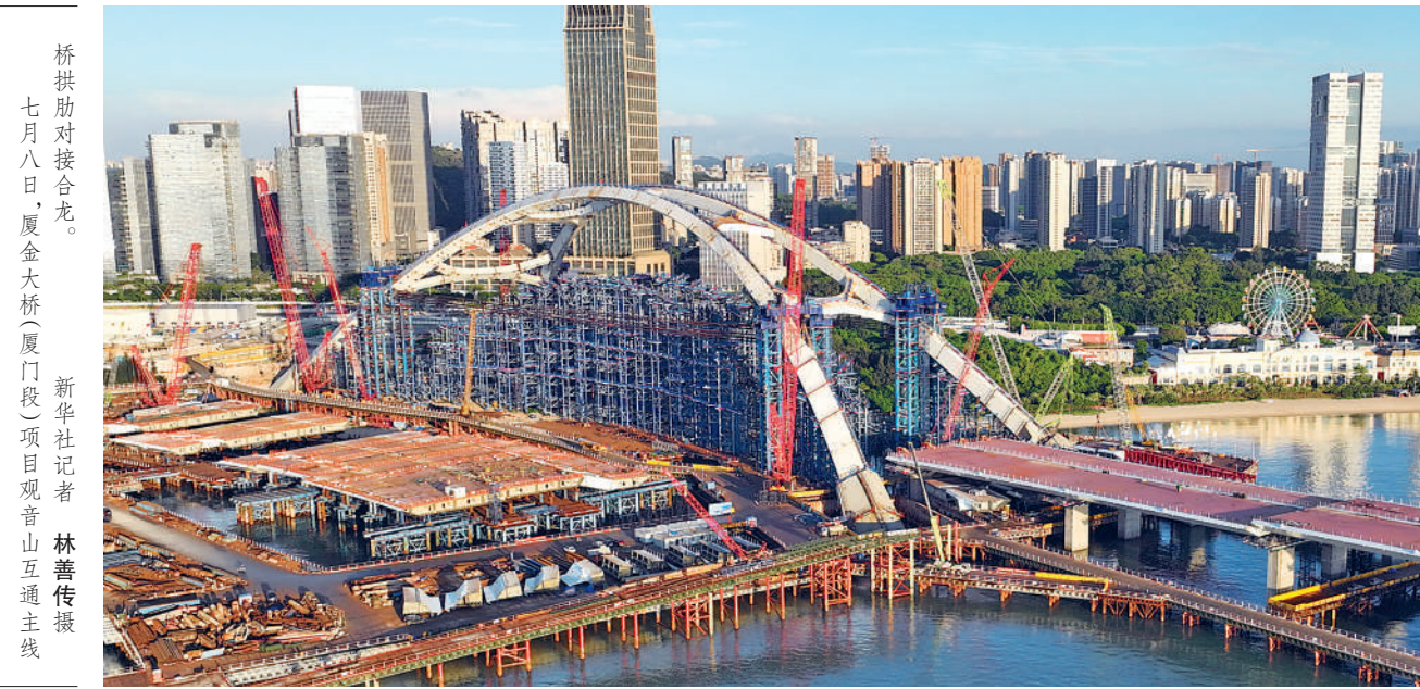
桥拱肋对接合龙。七月八日,厦金大桥(厦门段)项目观音山互通主线 新华社记者 林善传 摄
