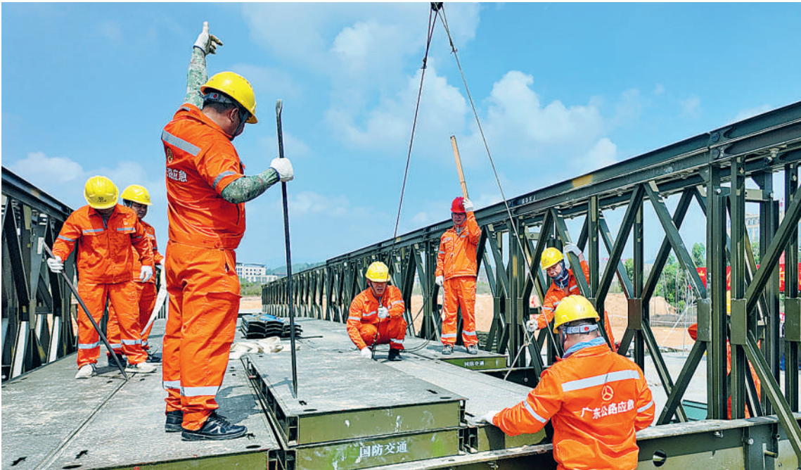
近日，广东省部分国防交通专业保障队伍在汕尾市开展公路钢桥架设训练、锤炼遂行任务和协同作业能力。图为参训人员练习钢桥零部件组装方法。
