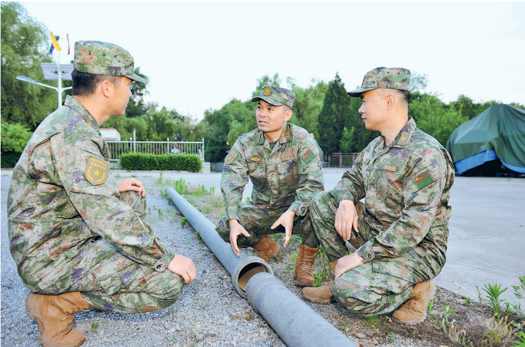
军事科学院系统工程研究院某所科研人员开展野战输油管线铺设试验。
