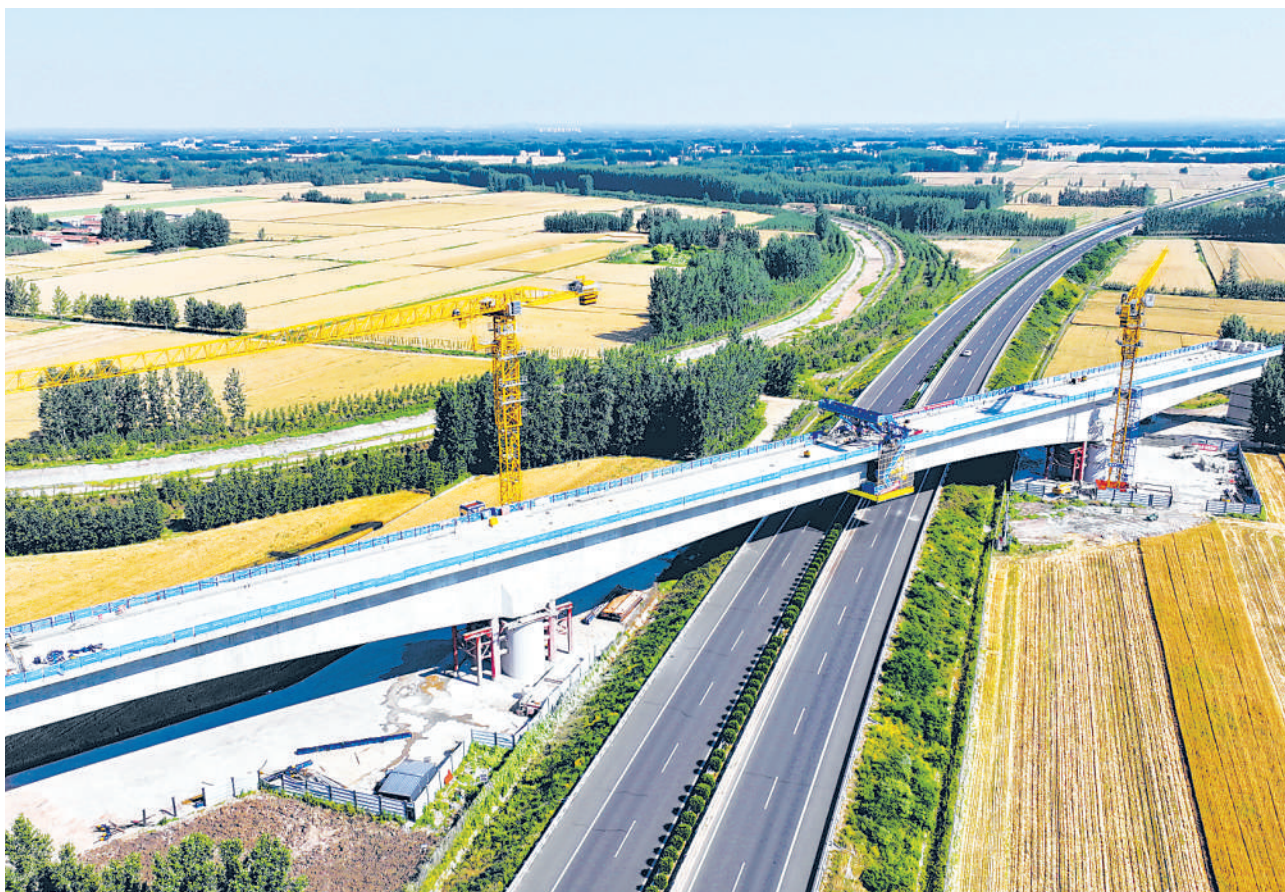
6月11日，淮（坊）宿（迁）高铁诸城淮河特大桥跨淮（坊）日（照）高速连续梁顺利合龙，为后续各项施工奠定基础。图为当日拍摄的施工现场。
