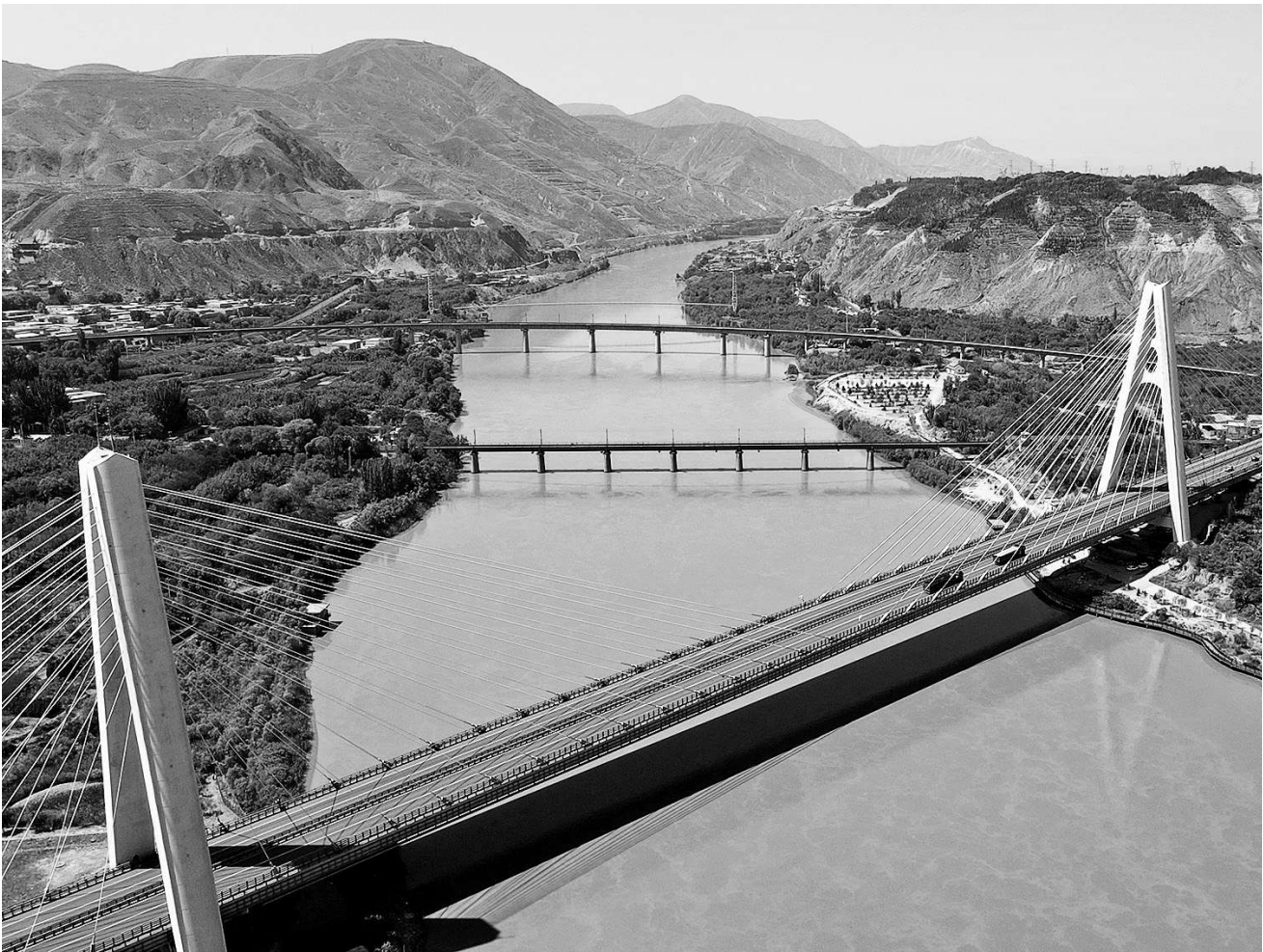
航拍兰州某横跨黄河的高速公路大桥。
