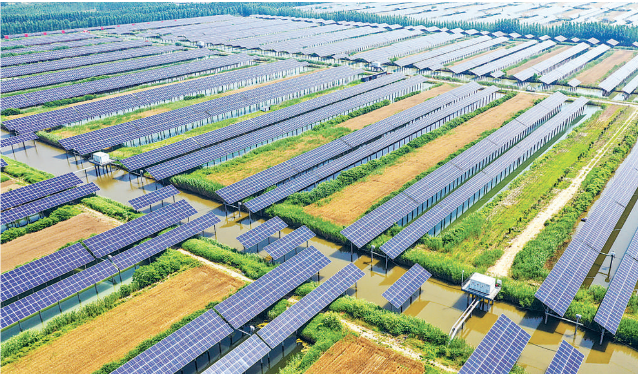
山东省近年来因地制宜探索实施农光、渔光、盐光、油光等“光伏+”互补模式，不仅提升了清洁能源供给能力，也通过“一地两用、一业多收”，增加了村集体收入和农民收益，走出了一条清洁能源、生态环境与经济效益“三赢”的绿色发展之路。图为6月2日拍摄的山东省滕州市滨湖镇煤矿塌陷地“渔光互补”项目。
