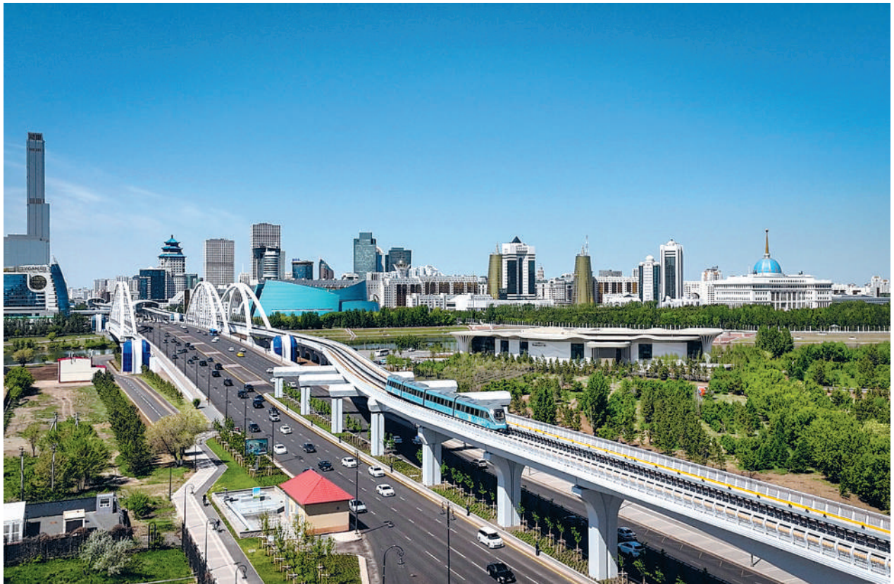
由中国企业承建的哈萨克斯坦首都阿斯塔纳轻轨项目一期工程近日举行通车仪式。图为在哈萨克斯坦阿斯塔纳拍摄的轻轨列车。 新华社发
