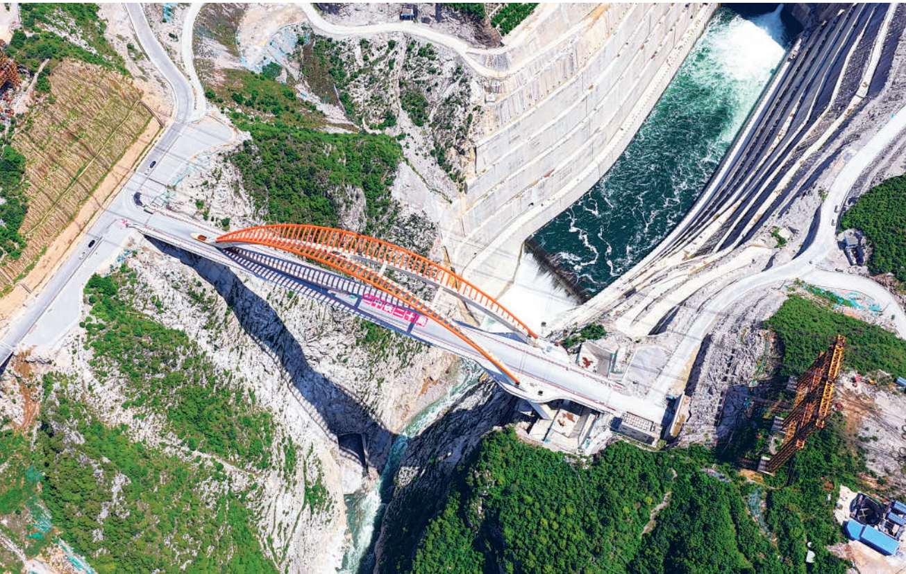
我国首例中承式空间Y型钢箱拱桥完工
