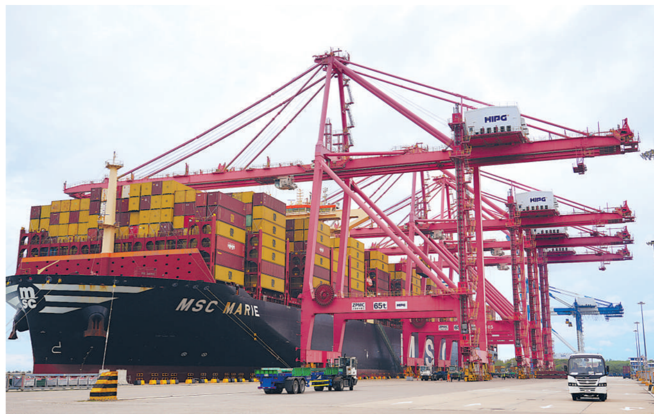
汉班托塔港是中共共建“一带一路”重点合作项目,位于斯里兰卡南端,是一座综合性人工深水海港。2026年一季度,汉班托塔港实现货物吞吐量201.54万吨,同比增长47%。图为4月23日拍摄的斯里兰卡汉班托塔港1号和2号泊位。
