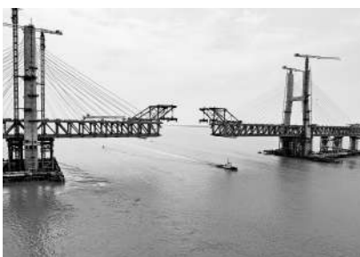
4月16日，沪渝蓉高铁沪宁段关键控制性工程崇启公铁长江大桥即将合龙。
