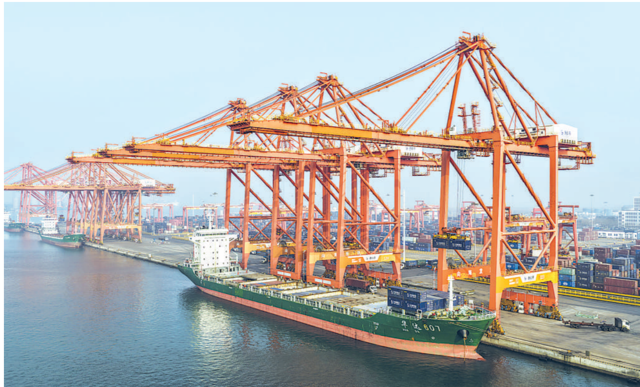
今年1至3月份,唐山港全港完成货物吞吐量21548万吨,同比增长3.67%。其中外贸吞吐量9932万吨,同比增长10.27%。图为4月17日轮船靠泊在唐山港京唐港区集装箱码头进行装卸作业。 新华社发
