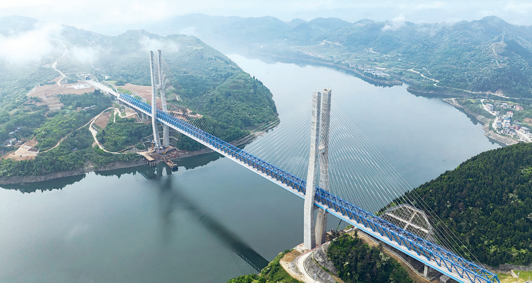
4月15日，西十高铁湖北段正式启动重联动车组逐级提速试验。西十高铁西起陕西西安，穿越秦岭山脉，终点为湖北十堰，正线全长256.938公里，设计时速350公里，是武汉至西安高铁的重要段落和福银通道的重要组成部分。图为当日拍摄的西十高铁汉江特大桥(无人机照片)。
