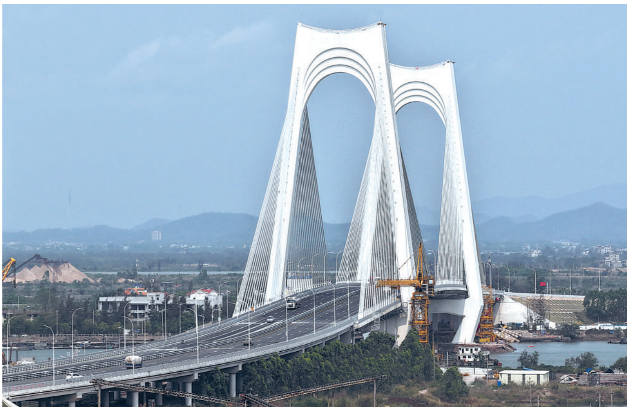
3月31日，地处广西钦江入海口的平陆运河沙井钦江大桥建成通车。图为当日拍摄的平陆运河沙井钦江大桥（无人机照片）。新华社记者 周华摄
