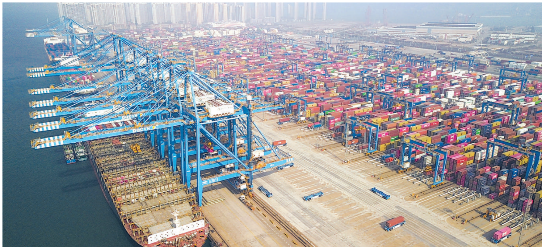
青岛港全自动化集装箱码头位于青岛前湾港区南岸，共有6个泊位，可停靠20万吨级集装箱船，是全国首个全自主自动化码头，全球领先。图为3月25日，该码头正在进行集装箱装卸作业。新华社记者 徐进摄
