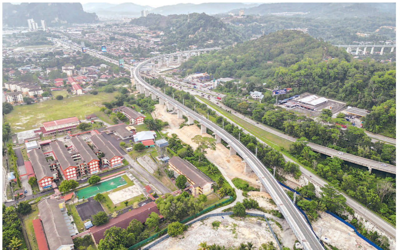
近日,中国企业承建的马来西亚东海岸铁路(马东铁)项目哥打巴鲁至鹤唳段轨道正式铺通。图为马来西亚雪兰莪州鹤唳车站附近的马东铁项目轨道。马东铁项目是中马两国共建“一带一路”合作的旗舰项目,设计全长600多公里。其中,哥打巴鲁至鹤唳段为一期工程,计划于2027年1月开通运营。 新华社记者 陈泽国摄
