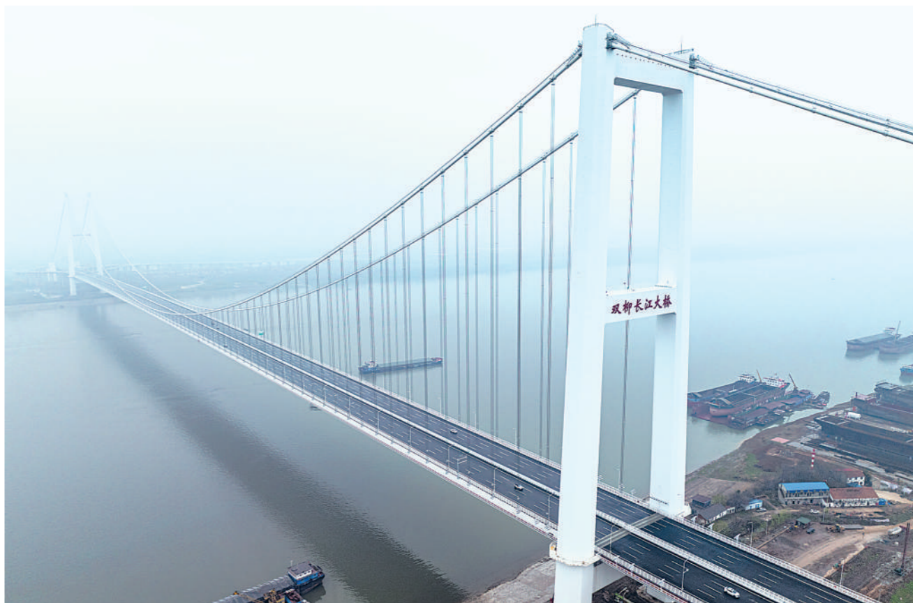
3月20日,双柳长江大桥正式通车。该大桥是武汉都市圈环线高速公路跨越长江的控制性工程,主桥主跨1430米,采用双向8车道,设计时速120公里。新华社记者 肖艺九摄
