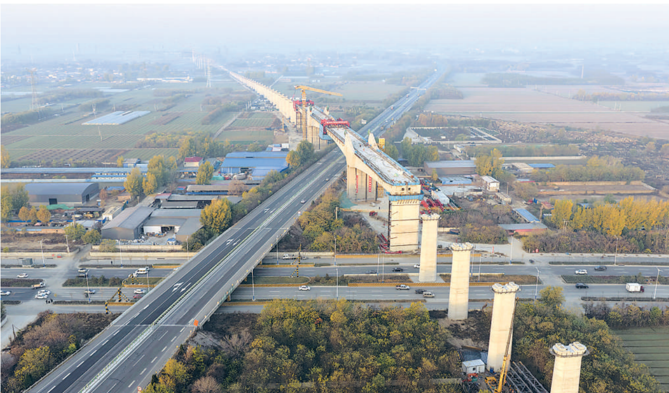
11月15日，雄忻高铁跨保沧高速特大桥桥拱顺利合龙，标志着项目建设取得重大进展，为后续架梁、铺轨作业奠定了坚实基础。 新华社记者 邢广利摄
