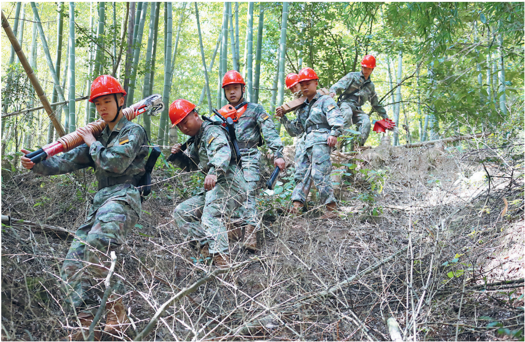
火箭军某部电力巡线分队官兵穿越深山密林检修线路。
