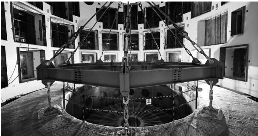
紧凑型聚变实验装置(BEST)的杜瓦底座成功落位安装。
