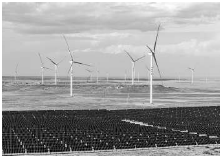
新疆阿勒泰地区吉木乃县50万千瓦风电项目配套输电线路建设现场。
