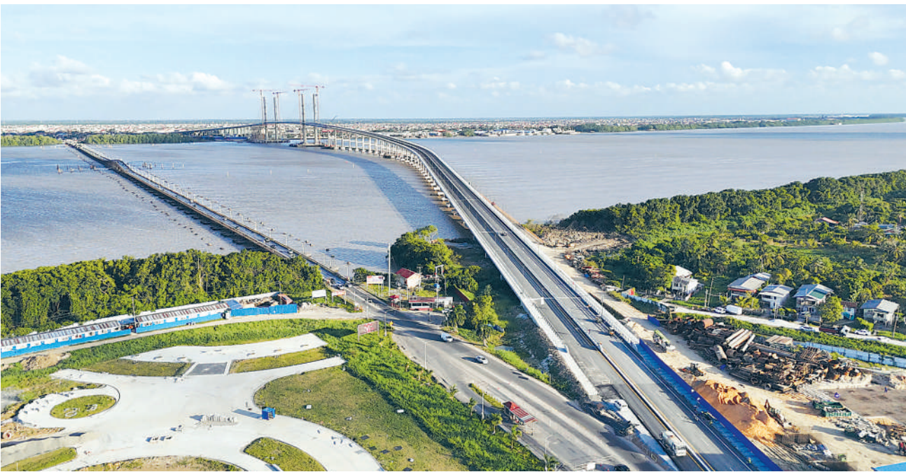
由中国铁建国际集团有限公司承建的圭亚那巴拉特·贾格迪奥-德梅拉拉河大桥10月5日正式通车。图为近日在圭亚那首都乔治敦拍摄的巴拉特·贾格迪奥-德梅拉拉河大桥。
