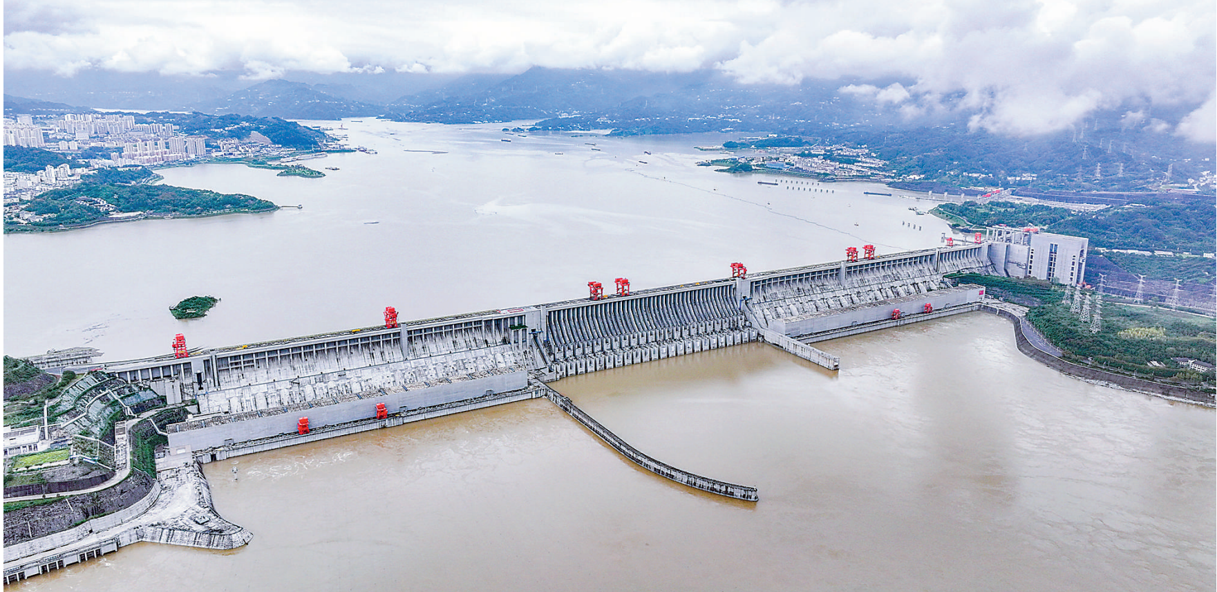
连绵阴雨初歇，位于湖北宜昌的三峡大坝云雾缭绕，气象万千。图为10月4日拍摄的三峡大坝（无人机照片）。
