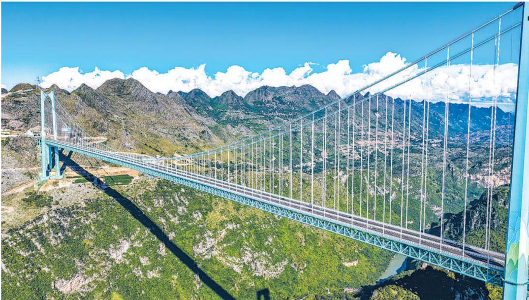
9 月 28 日，世界第一高桥——贵州花江峡谷大桥建成通车。花江峡谷大桥是贵州六枝至安龙高速公路的控制性工程，大桥全长 2890 米，主跨径 1420 米，是目前世界山区峡谷第一大跨度钢桁梁悬索桥；其桥面距水面垂直高度 625 米，是新的世界第一高桥。
