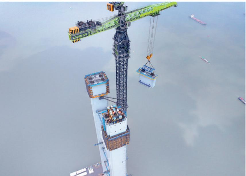
九月十四日，张靖长江大桥南航道桥南主塔顺利完成第二十六个节段吊装。该大桥连接江苏省泰州、泰州和南通，跨江段全长七千八百五十九米。
