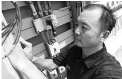
孙昌友正在检修设备。
