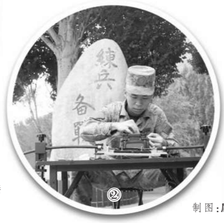
图①：战士正在检修光缆；图②：战士训练光缆连接修复；图③：官兵前往故障点维修光缆。
