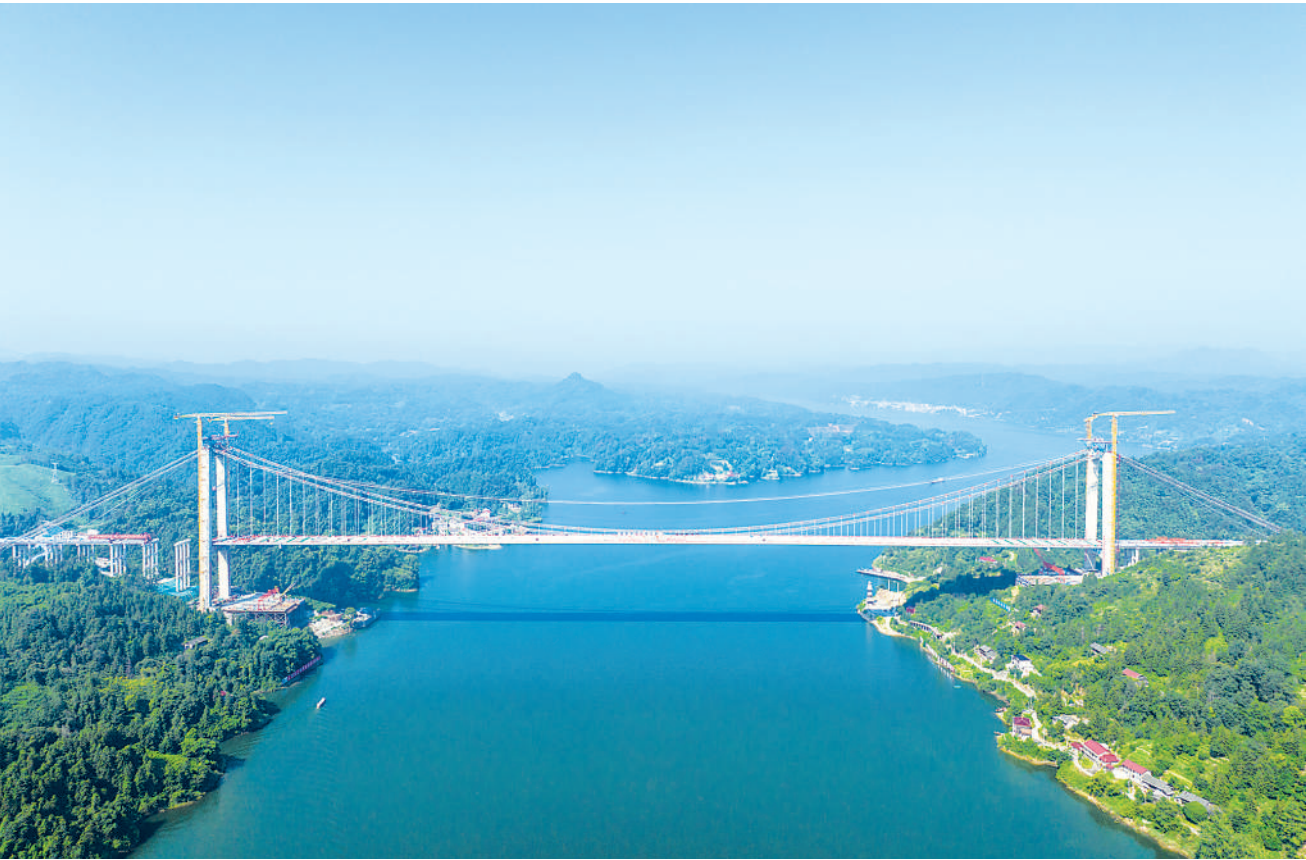
8月3日，张官高速控制性工程洞庭溪沅水特大桥主桥顺利合龙，为2026年全线通车奠定了坚实基础。据了解，洞庭溪沅水特大桥位于湖南怀化市沅陵县境内，全长1707米，主桥长800米，为双塔单跨悬索桥。图为当日拍摄的施工中的张官高速洞庭溪沅水特大桥（无人机照片）。
