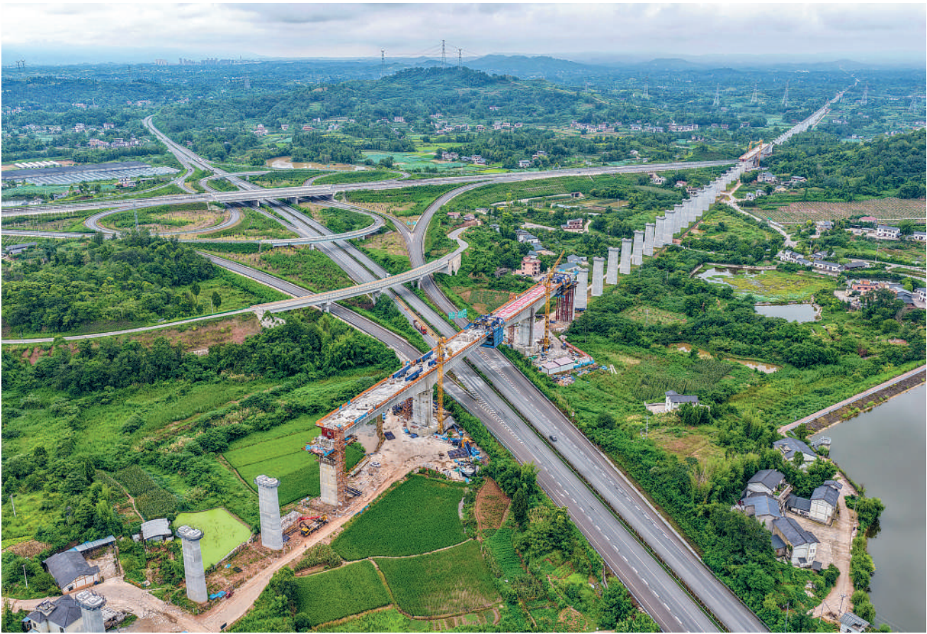
7月8日，成渝中线高铁土桥枢纽互通双线特大桥连续梁顺利合龙。该连续梁全长约242米，是成渝中线高铁重庆段跨度最大的连续梁。
