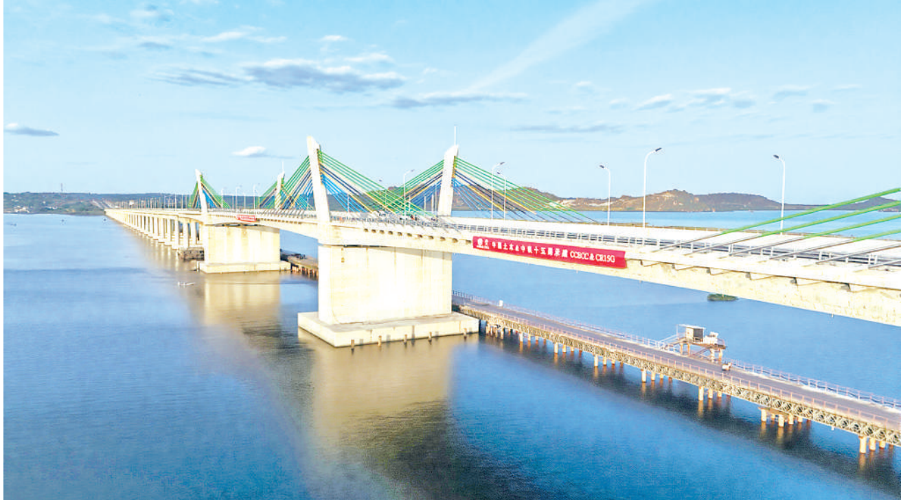
近日，由中企承建的非洲最长矮塔斜拉桥坦桑尼亚马古富力大桥项目正式建成通车。马古富力大桥通车使维多利亚湖两岸原本2个多小时的通行时间缩短至5分钟左右，将成为推动坦桑尼亚深化与邻国贸易往来的关键枢纽。图为在坦桑尼亚姆万扎省拍摄的马古富力大桥。
