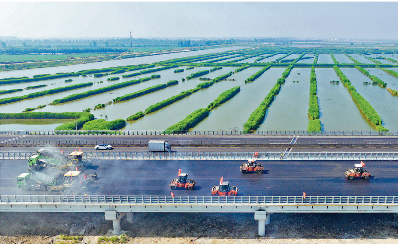
6 月 23 日,随着最后一段沥青摊铺机作业完工,京哈高速改扩建工程盘锦段实现主线贯通,为后续建成通车奠定基础。图为当日施工车辆进行沥青摊铺作业(无人机照片)。 新华社记者 杨青摄
