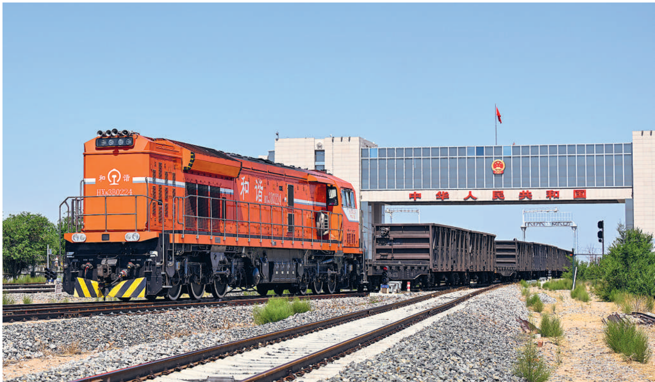
二连浩特口岸位于我国正北方,是我国对蒙古国开放的最大陆路口岸、向北开放的重要桥头堡。图为近日一列中欧班列通过内蒙古二连浩特铁路口岸入境。 新华社记者 贝 赫摄
