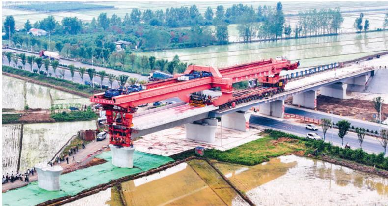
6月21日，淮(坊)宿(迁)高铁山东临沂段首榀箱梁架设成功，正式进入线上架梁施工阶段。图为当日在淮宿高铁郑城沂河特大桥施工现场，工作人员在进行箱梁架设。新华社记者郭绪雷摄
