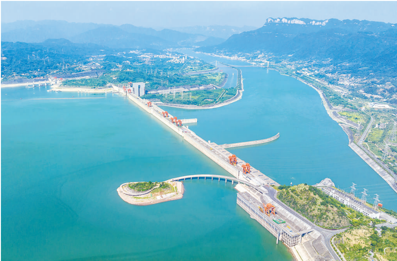
6月13日8时，三峡水库水位消落至150米，释放超八成防洪库容，正式转入汛期防洪调度阶段。图为当日在湖北省宜昌市秭归县拍摄的三峡枢纽。
