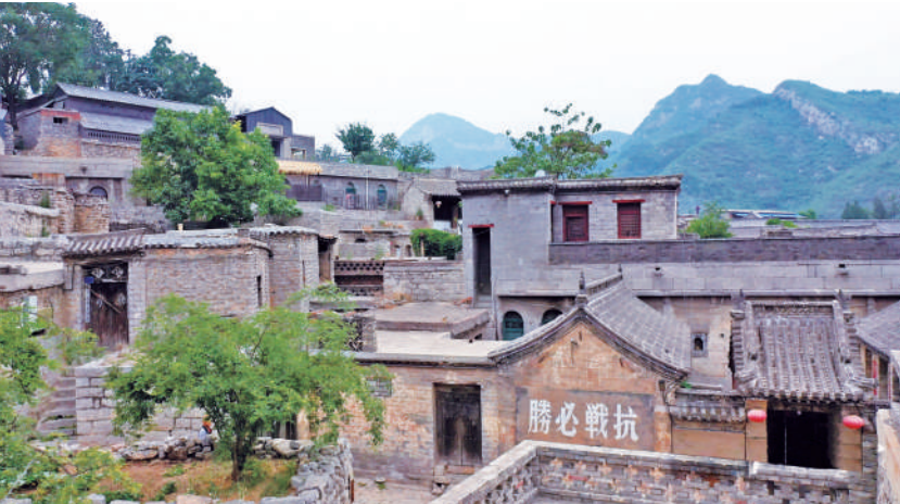
位于河北省石家庄市井陘县吕家村的长生口伏击战指挥部旧址。资料照片
