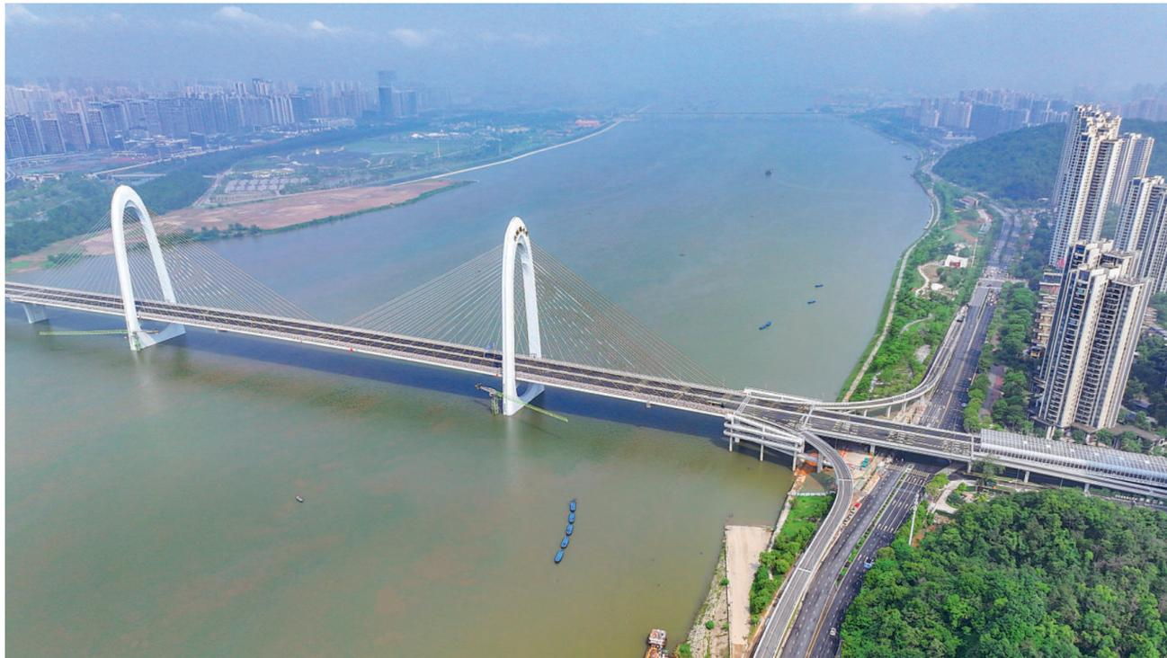
4月28日,长沙兴路大桥通车试运行。据了解,该桥梁项目路线全长5.475公里,主桥长4.96公里,跨湘江主桥为双塔斜拉桥,设双向八车道,是长沙北部城区一条横贯东西的快捷通道。图为当日拍摄的长沙兴路大桥(无人机照片)。
