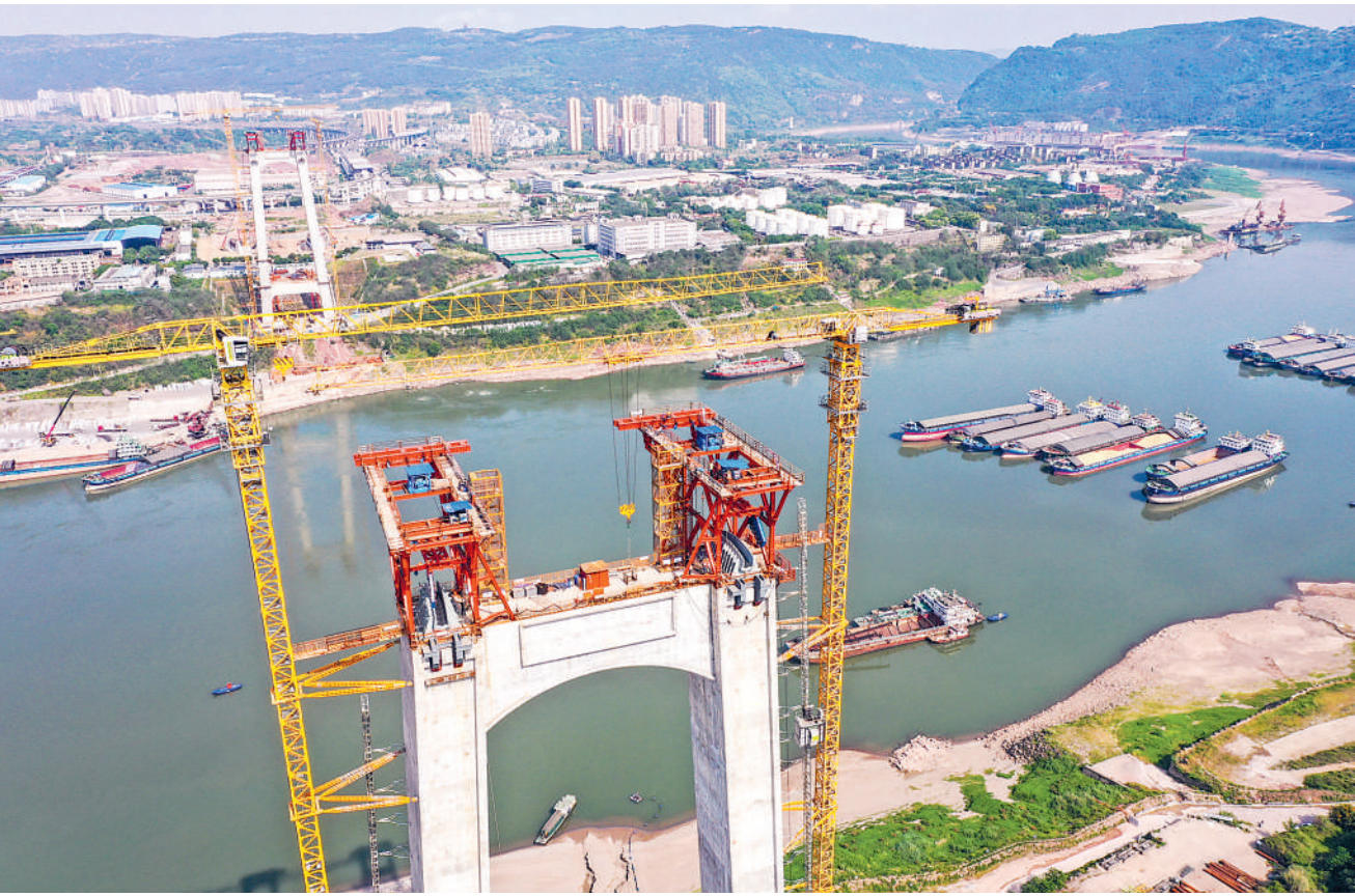
4月19日，重庆黄桷沱长江大桥先导索经交通艇牵引跨越长江，大桥南、北两岸主塔顺利完成“牵手”。黄桷沱长江大桥是渝长高速复线连接道工程的控制性节点工程，建成后将成为联系重庆主城区长江南北两岸的重要交通干道。图为当日拍摄的黄桷沱长江大桥先导索架设作业现场。
