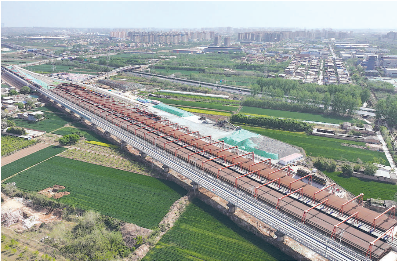
4月18日,西延高铁全线铺轨施工正式启动,西延高铁建设进入最后攻坚阶段。西安至延安高速铁路全长299.8公里,是陕北革命老区的首条高铁。图为当日拍摄的位于陕西省西安市阎良区的西延高铁铺轨基地(无人机照片)。 新华社记者 张博文摄
