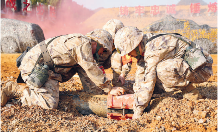
日前，贵州省兴仁市人武部组织民兵应急分队开展专业课目训练，提升民兵应急处置能力。图为民兵开展供水设施抢修训练。
