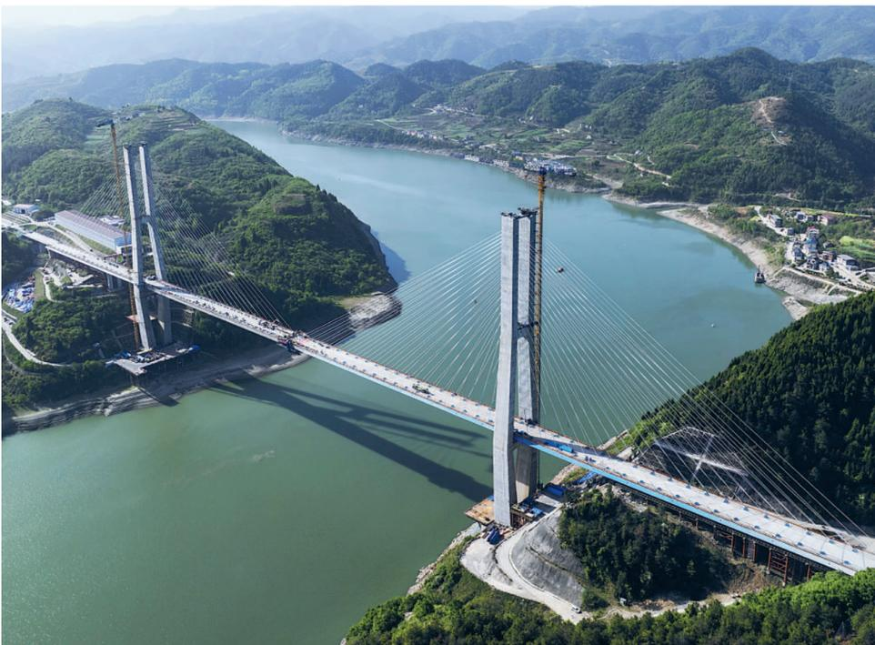
4月14日,西(安)十(堰)高铁汉江特大桥顺利合龙。汉江特大桥位于湖北省十堰市,全长917.45米,两座主塔高达186.5米,主跨420米。西十高铁西起陕西西安,向东南穿越秦岭山脉,终点为湖北十堰,正线全长255.76公里,设计时速350公里。西十高铁开通后,西安至十堰将实现1小时内到达,西安至武汉将实现2.5小时左右到达,对加强关中西部城市群与长江中游城市群联系,带动沿线经济社会发展等具有重要意义。图为当日拍摄的汉江特大桥(无人机照片)。
