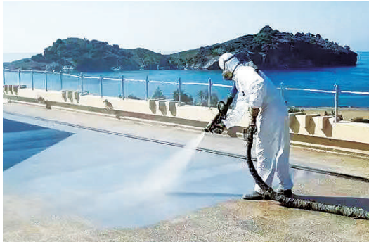
作为防水材料喷涂在屋顶的聚脲涂层。
