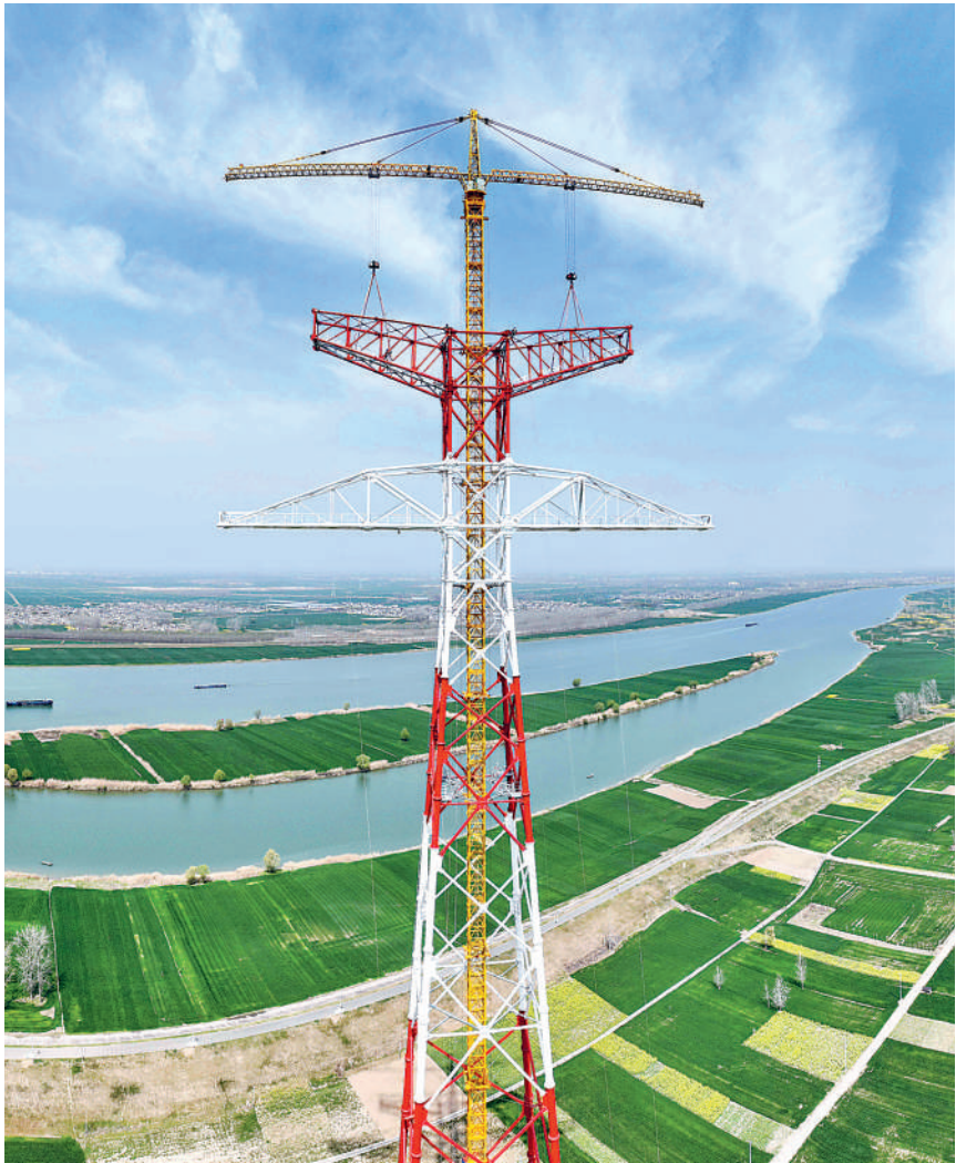
4月1日,经过建设者27天的奋战,安徽香涧至鹭岛500千伏线路工程淮河南岸跨越塔成功封顶。图为当日,在安徽省滁州市凤阳县淮河边,安徽送变电工程有限公司施工人员在高空进行输电塔封顶作业(无人机照片)。 新华社记者 杜宇摄
