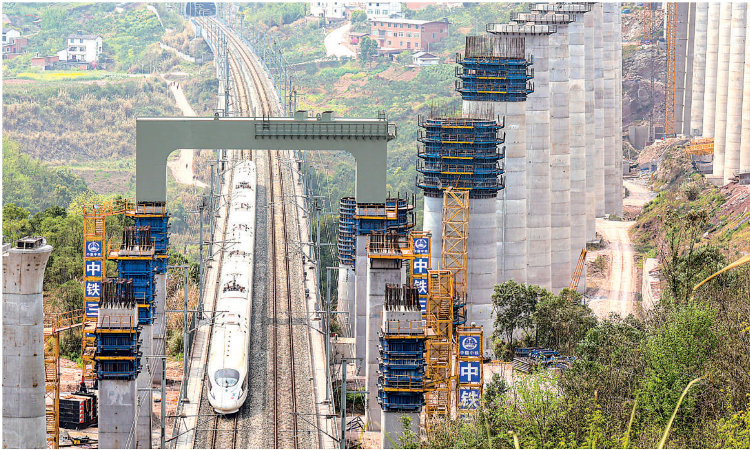
3月27日凌晨，在成达万高铁左线福寿跨渝万城际特大桥项目施工现场，一捆重达165.8吨的门式墩钢横梁稳稳落在支座上，标志着成达万高铁首个跨既有高铁钢横梁吊装完成。成达万高铁建成后，将形成成都直达中原和京津冀地区的便捷客运通道。图为郑渝高铁线上一列动车从门式墩钢横梁下通过。 新华社发
