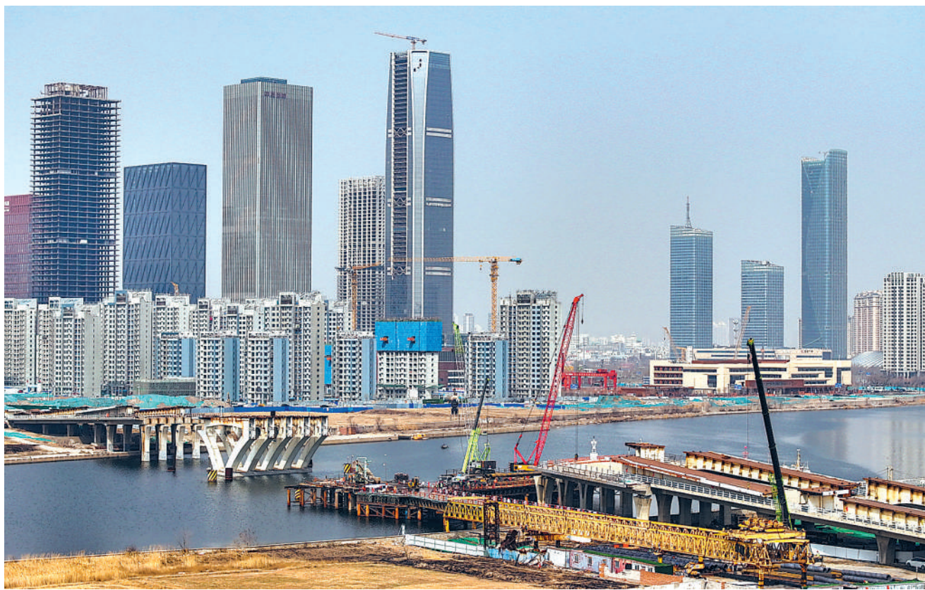
连日来,位于天津市滨海新区的安阳桥、于新桥改建工程现场,各项作业稳步推进。根据设计方案,两桥均将改建为开启式桥梁。“两桥”项目建成后,不仅将有效缓解该区域横跨海河的交通压力,还能为海河往来船只提供通航空间。图为3月13日拍摄的于新桥施工现场。
